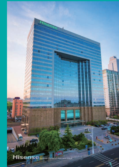
【本社ビル】 中国 青島にある本社ビル。世界で販売している最新のハイセンス製品や取り組みを紹介するショールームが併設されています。
